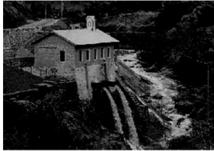
Figura 1 – Usina hidrelétrica marmelos zero. Extraído de (ELETROBRAS, 2013)
